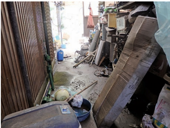
床下浸水／熊毛組 光照寺
