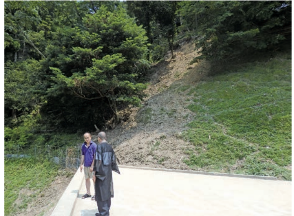
斜面崩落／大津東組 浄土寺
