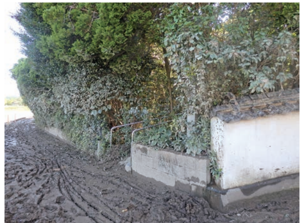
床上浸水（高さ2m）／熊毛組 眞行寺
